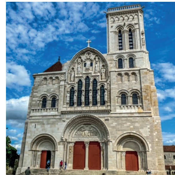
La façade principale Die Hauptfassade
